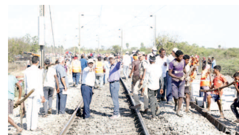
ట్రాక్ పునరుద్ధరణ పనులను పర్యవేక్షిస్తున్న దక్షిణ మధ్యరైల్వే జిఎం అరుణ్ కుమార్ జైన్ ఇతర అధికారులు
